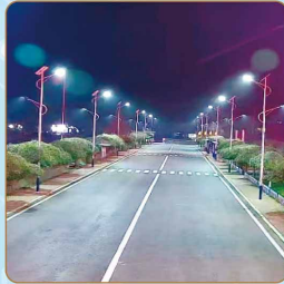
中电为学校安装太阳能路灯。
