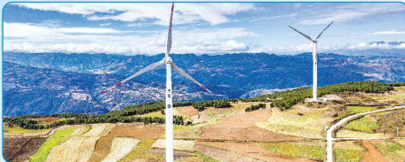
Yunnan Xundian II Wind Farm
